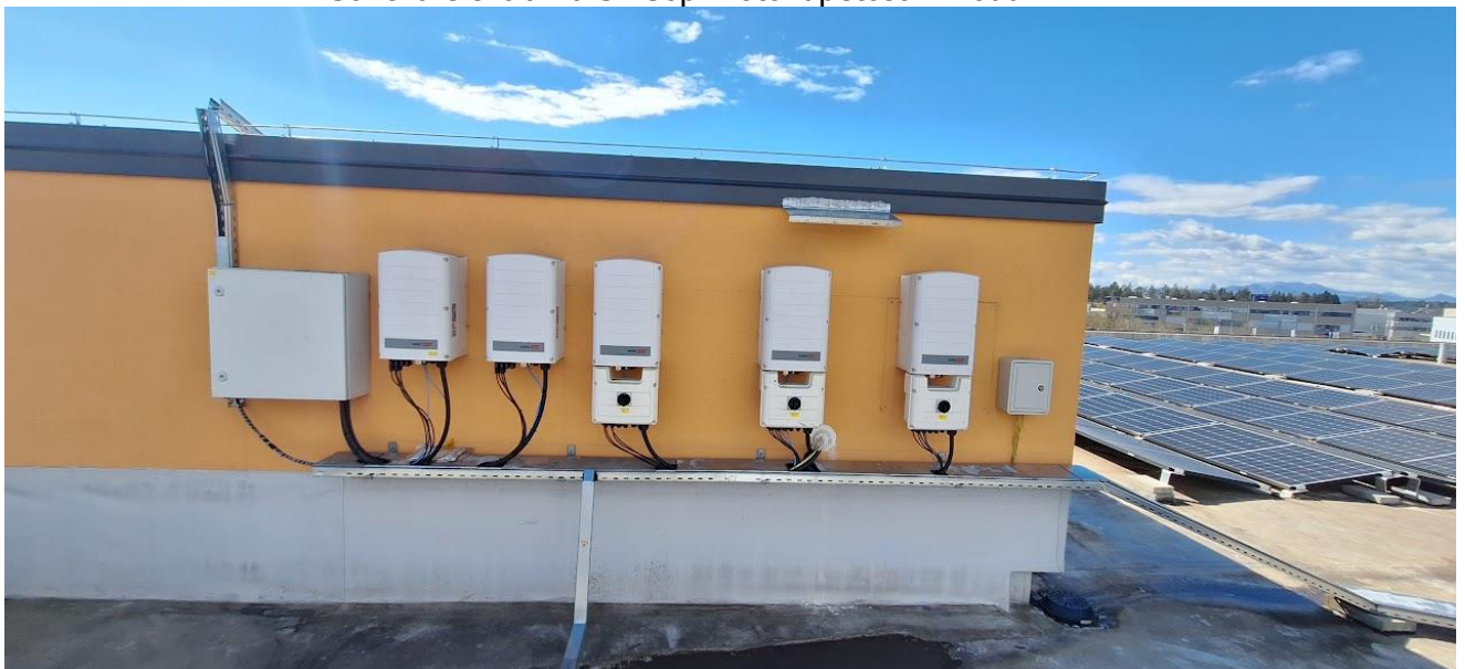
Nameščeni razsmerniki na strehi – možnost izklopa DC napetosti
