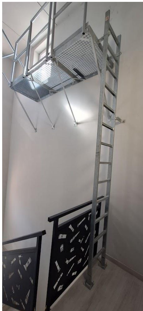
Dostop na streho objekta preko lestve in podesta- I. nadstropje
