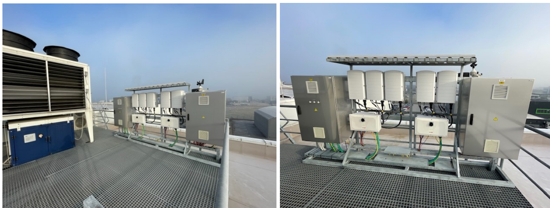
Slika: Razsmerniki (3+2) – streha objekta B – območje med objektoma
