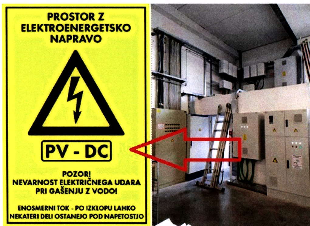
Slika 16: slika lokacija DC omarice, izklop glavno stikalo pri dvigalu in pred komp. postajo
