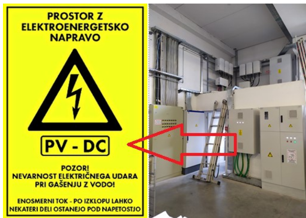
Slika 15: slika lokacija DC omarice, izklop glavno stikalo pri dvigalu in pred kompresorsko postajo
