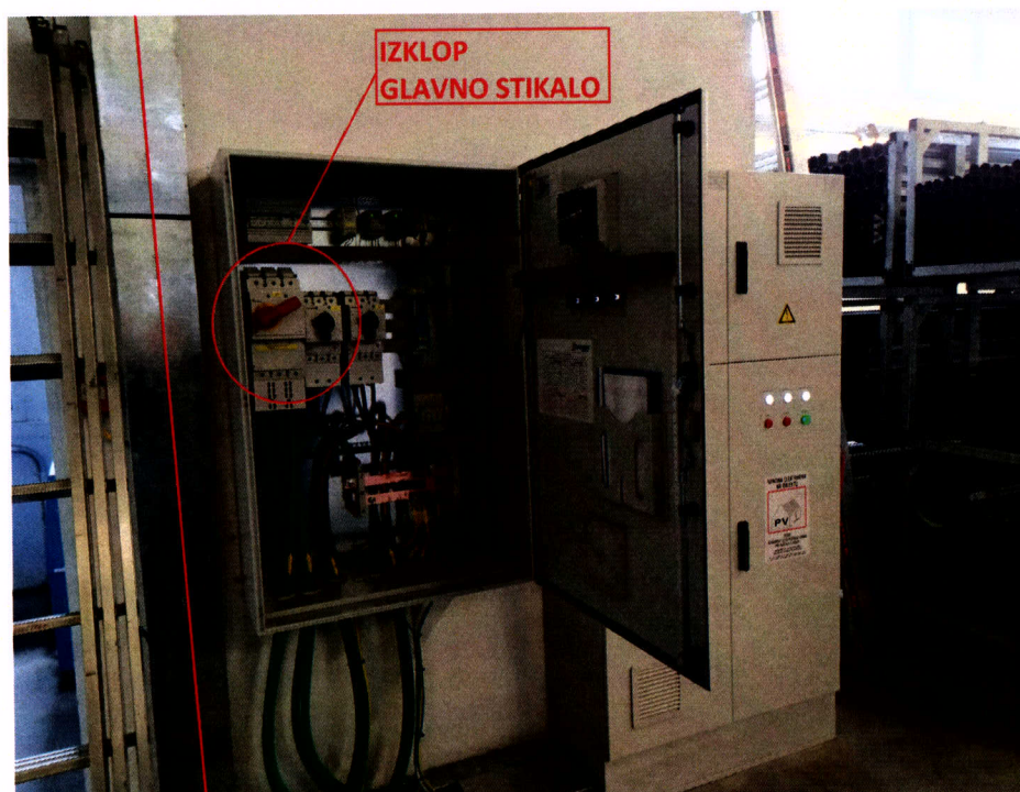
SLIKA 18: Glavno stikalo za vklop in izklop MFE Tehrol d.o.o. se nahaja v elektromarici pred vhodom v kompresorsko postajo (pritličje - proizvodnja) s stikalom 0 in 1. DOSTOP JE DOVOLJEN LE STOKOVNO ELEKTROTEHNIŠKO USPOSOBLJENIM OSEBAM!
