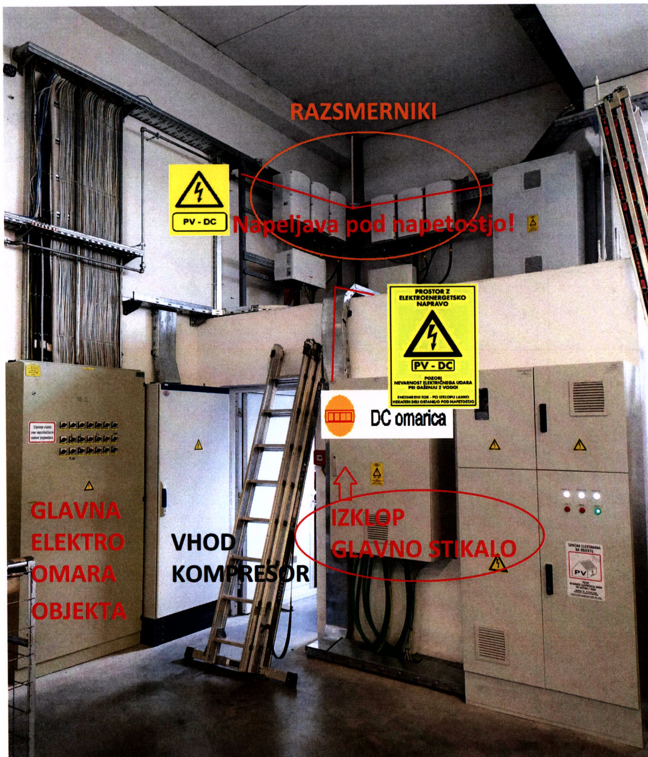
Slika 17: slika lokacija DC omarice, izklop glavno stikalo pri dvigalu in pred kompresorsko postajo, razsmerniki nad kompresorsko postajo. Napeljava pod napetostjo (PV-DC) in glavna elektro omara objekta
