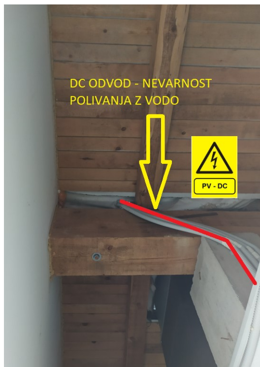
SLIKA 11: slika levo preboj preko strehe do razsmernikov v strojnici v 2. nadstropju
