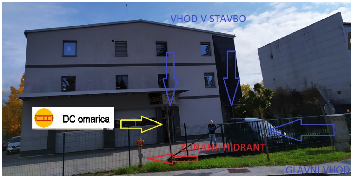
Slika 16: Obstoječi zunanji hidrant na zahodni strani ter vhodi ter policija Dc omarice z glavnim stikalo za izklop MFE Glaso d.o.o.
