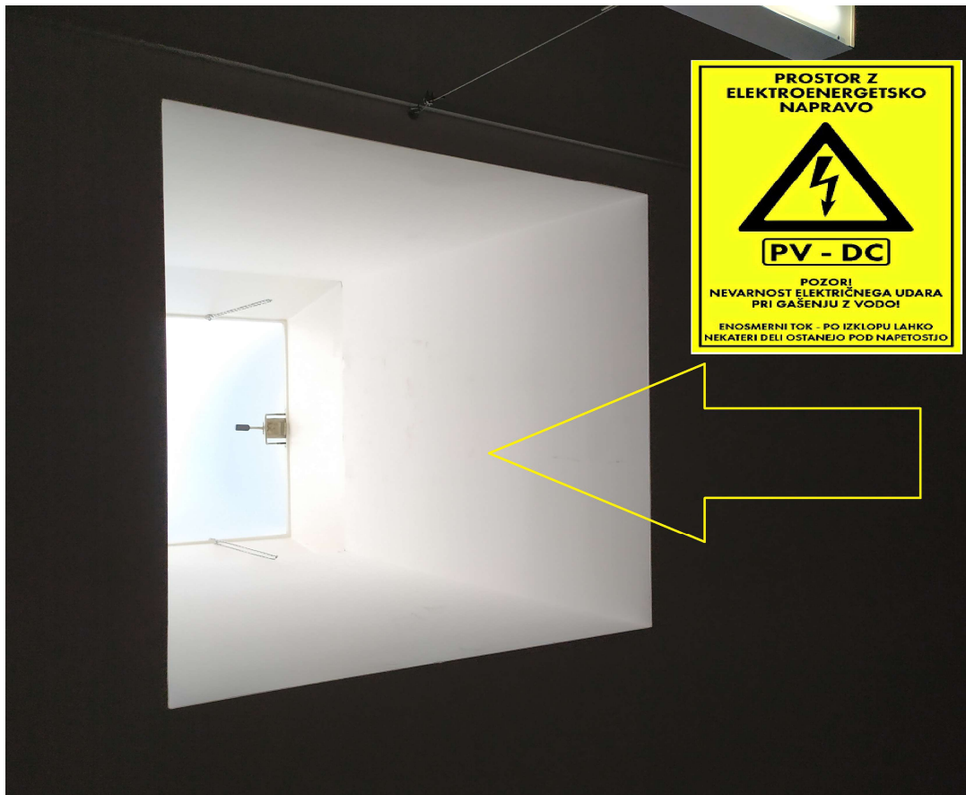
SLIKA 7: Dostop skozi jašek na streho (slikano iz prostora v drugem nadstropju)
