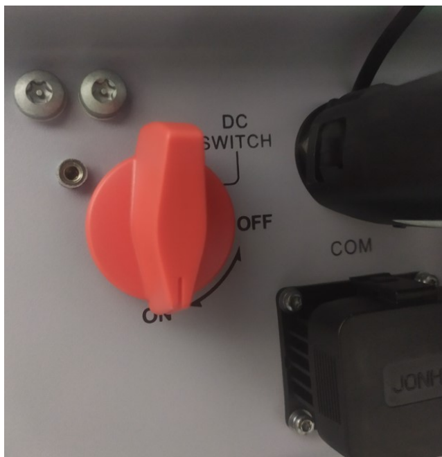
Slika 10: Razsmernik na desni strani s slike 7. - stikalo za IZKLOP RAZMERNIKOV NA SPODNJI STRANI RAZSMERNIKA - RDEČE STIKALO v 2. nadstropju
