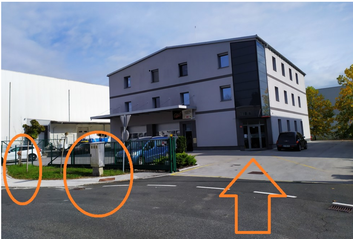
Slika 15: Južna stran skladiščnega objekta (od leve: zunanji hidrant, glavna elektrooomara Ljubljana Elektro , dostop in postavitvena površina za interventna vozila)
