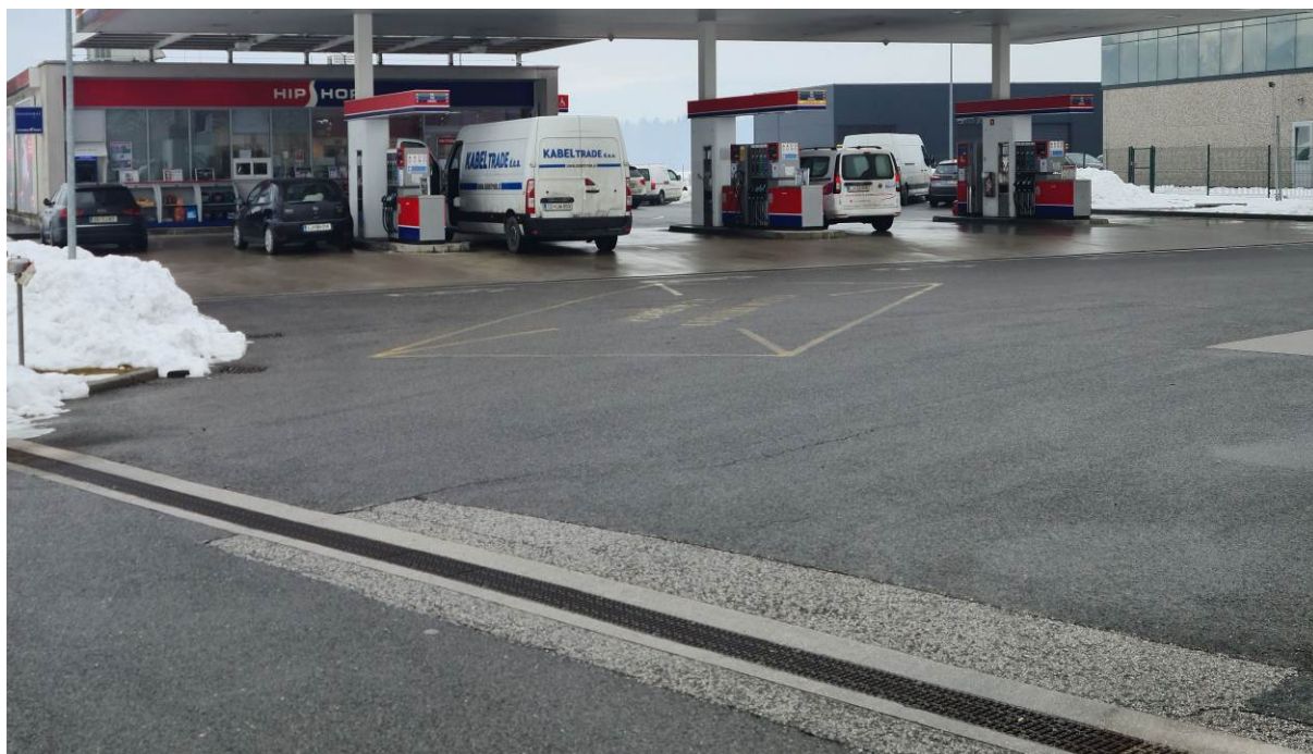
Slika 4: Ploščad bencinskega servisa s točilnimi napravami
