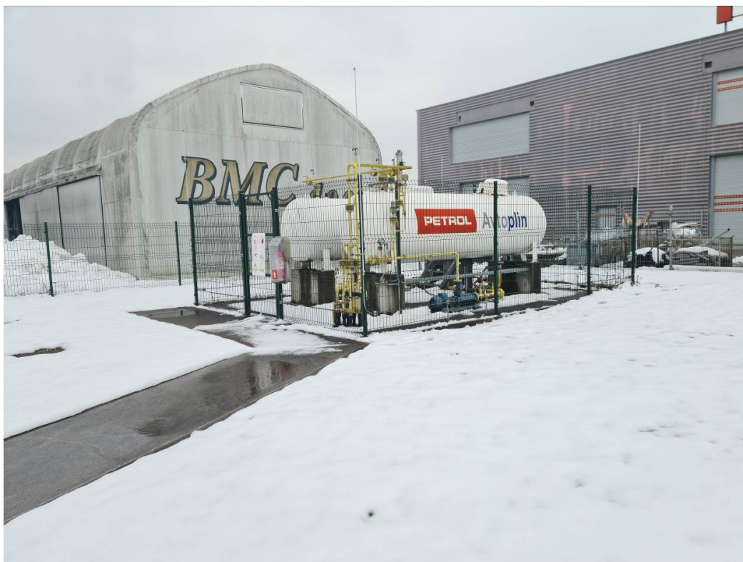
Slika 5: Nadzemna UNP rezervoarja
